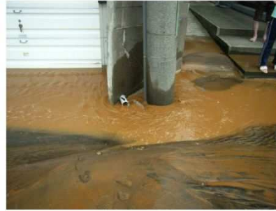
写真 本震12分後の噴砂・噴水と電柱の沈下(撮影地点⑮)
