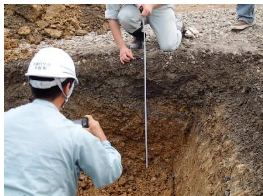
写真-1 掘削面の観察状況
