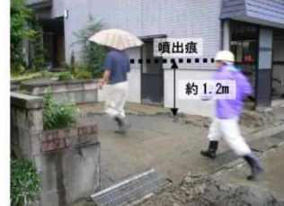
写真 宅地内の噴砂(旧河道上)
